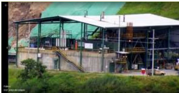
Antes del Colapso
